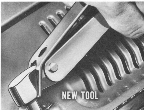
Fig. 21—Wiper arm tool C-3982
